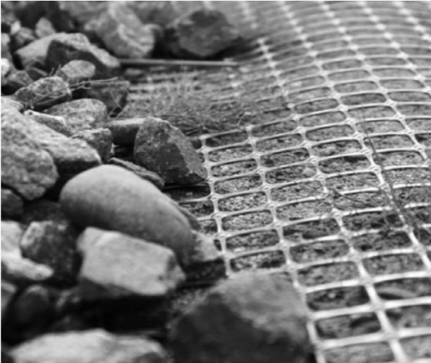
Рис. 3. Приклад встановлення геосітки
