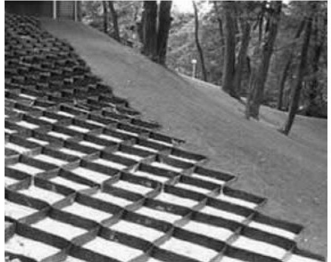
Рис. 4. Приклад встановлення георешітки
