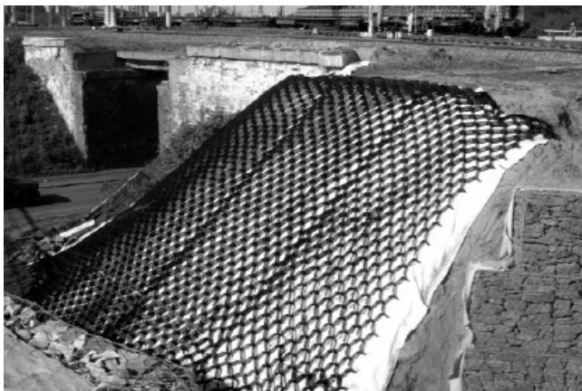
Рис. 1. Приклад влаштування геотекстилю на схилі
